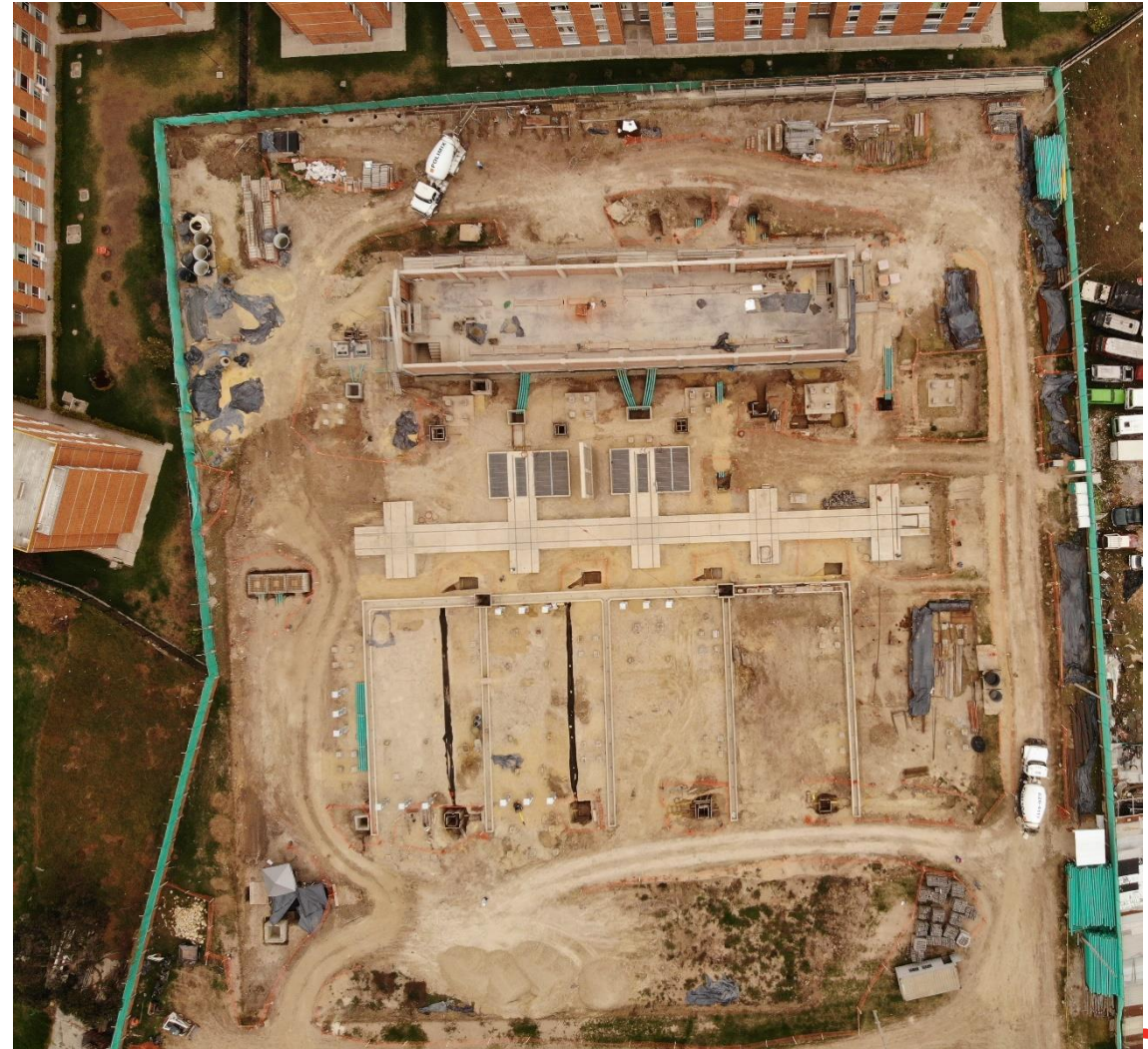
Estado obra a Noviembre 2019
