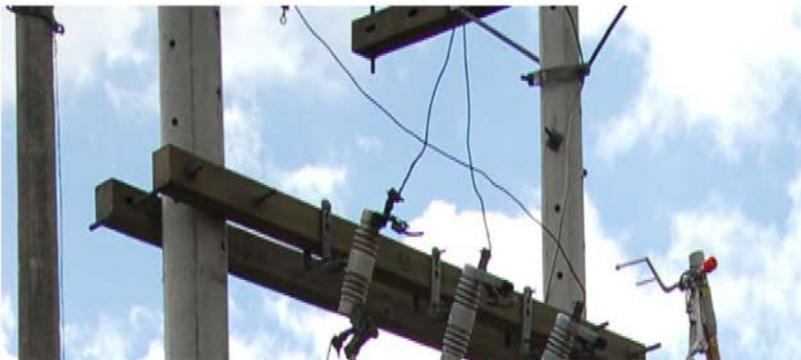
Una vez desenganchado el *Load Buster* se retira el adaptador AYE-AYE del soporte de llegada de la línea eléctrica desplazándolo hacia un costado.
