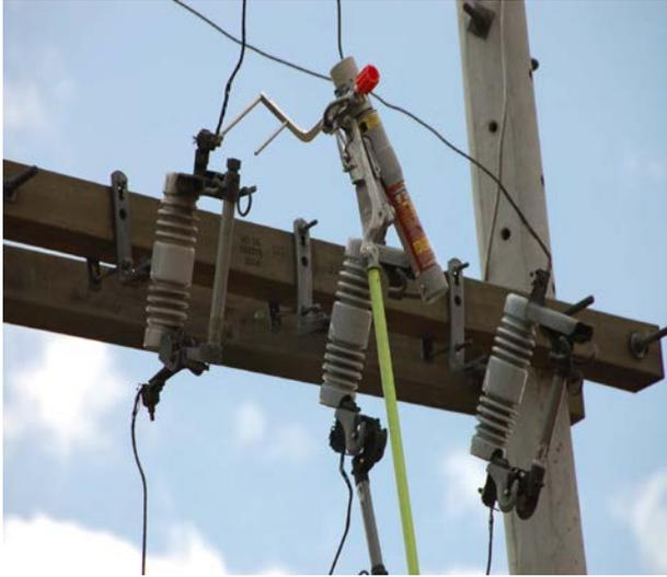
Una vez instalado el adaptador al Load Buster<sup>®</sup>, se aproxima la barra guía para enganche del AYE-AYE a la parte inferior interna del cortocircuito a desconectar, asegurándose que lo atraviese completamente y teniendo en cuenta que la barra superior de enganche esté ubicada sobre el soporte de llegada de la línea eléctrica.
