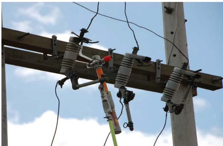
Se procede a extender el *Load Buster*® completamente con el fin de halar la cañuela e interrumpir la corriente.
